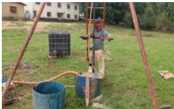
Figura 7 – Execução do furo SPT-02A.
