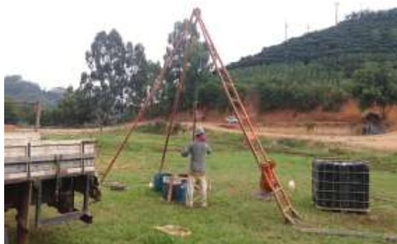
Figura 5 – Execução do furo SPT-02.
