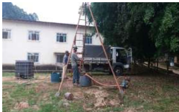
Figura 2 – Execução do furo SPT-01.
