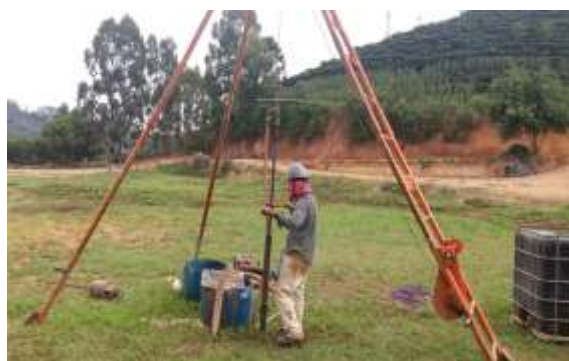
Figura 4 – Execução do furo SPT-02.
