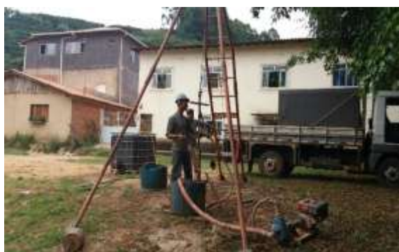
Figura 3 – Execução do furo SPT-01.
