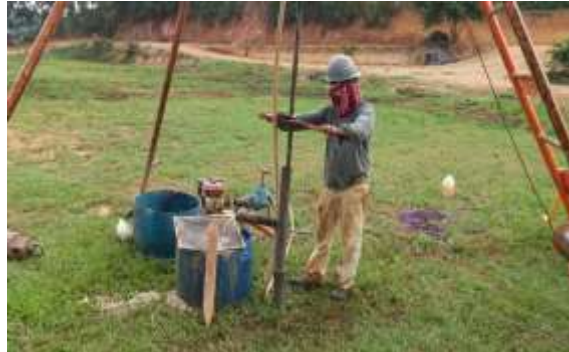
Figura 6 – Execução do furo SPT-02.
