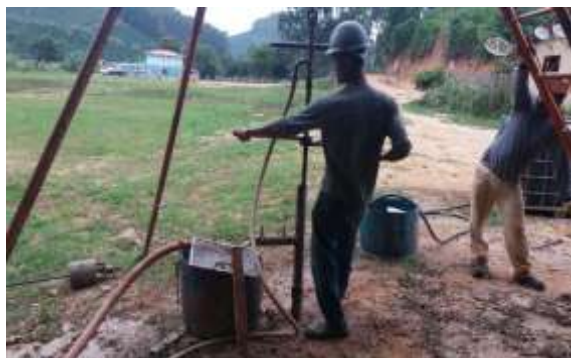
Figura 1 – Execução do furo SPT-01.
