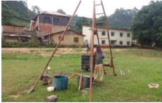
Figura 9 – Execução do furo SPT-02A.
