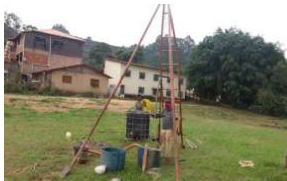
Figura 8 – Execução do furo SPT-02A.
